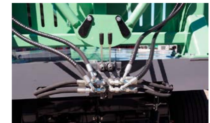
Steuerung an Fahrzeugfront
